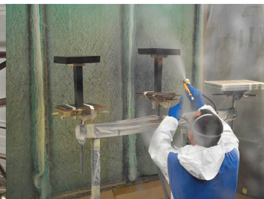
Nouvelle cabine de vernis
