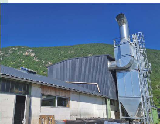
Mise en place des systèmes d'aspiration
